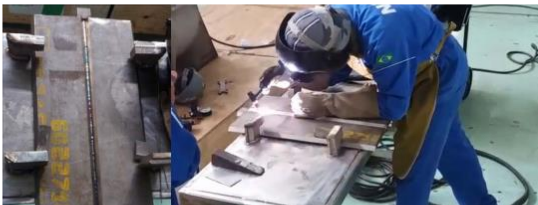
Figura 14: Soldagem GTAW do AISI 304L
